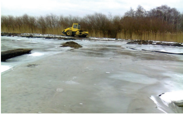
Fig. 5. Frozen construction site 02-2014
