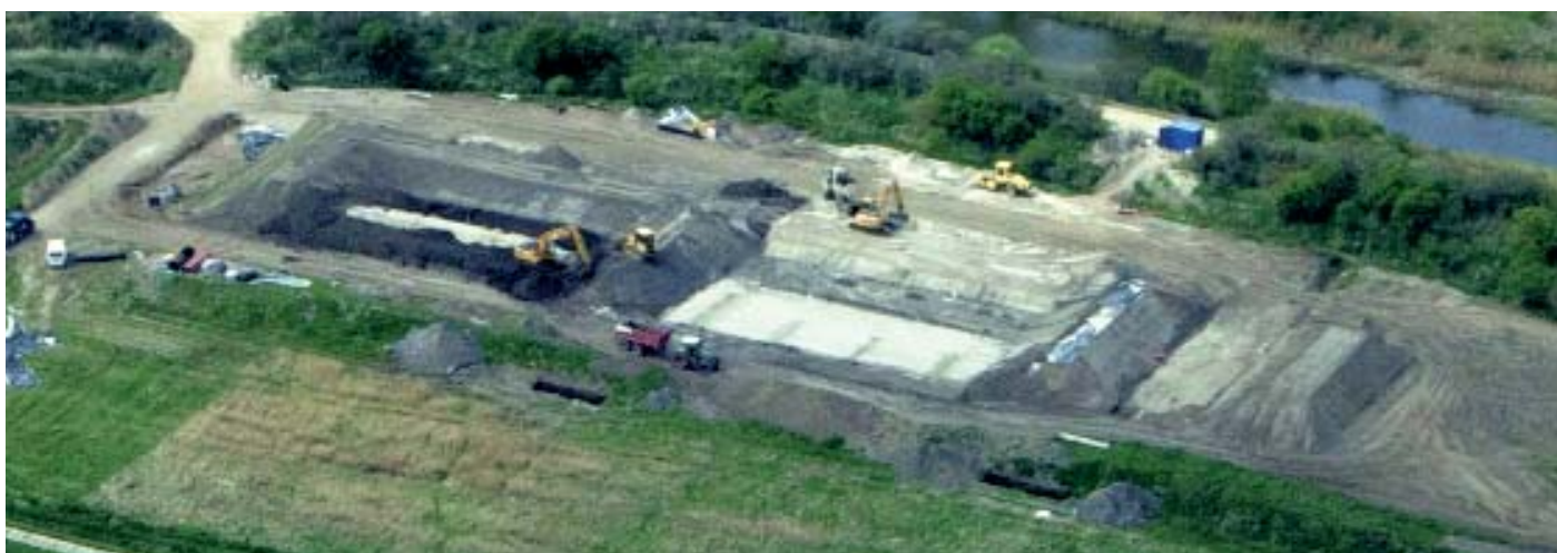
Budowa stanowiska badawczego w Niemczech – maj 2012
