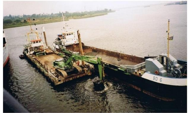
Abb. 2.1. Nassbaggerarbeiten am Warnowtunnel in Rostock, Baggerung von feinkörnigem organischem Baggergut
