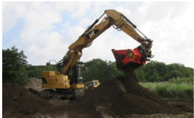
Abb. 5.3. Homogenisierung von Baggergut mit Separatorschaufel
