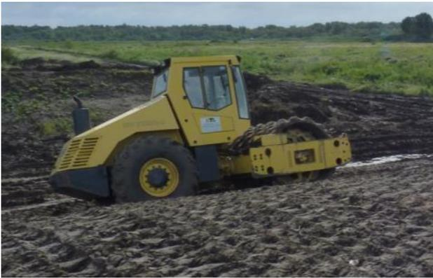
Abb. 5.4. BG-Verdichtung mit einer Schafffußwalze
