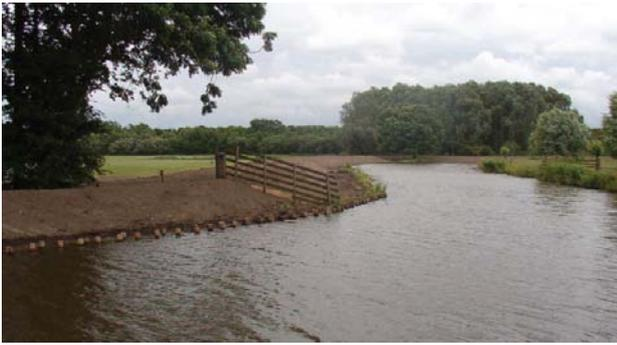
Abb. 2.16. Einbau von Baggergut am Ufer in den Niederlanden [19]
