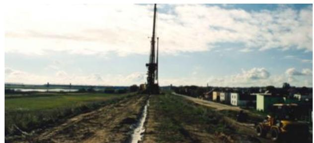
Abb. 5.8. Einbau einer Vertikaldichtung (Foto: Moebius Polska)
