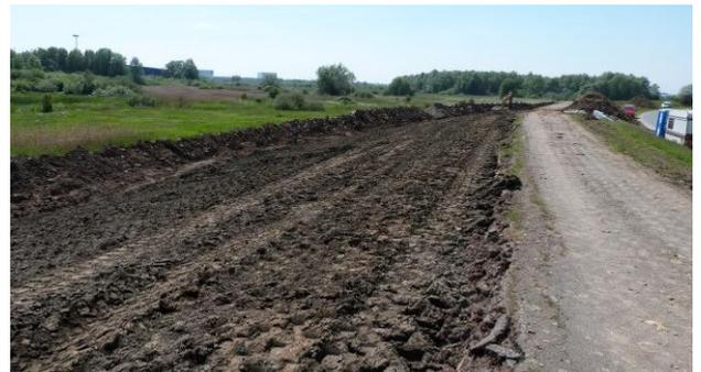
Abb. 2.14. Deichrekonstruktion in Bremen mit leicht belastetem Baggergut (Z2 + TBT), Baggerguteinbau im Sommer 2014.
