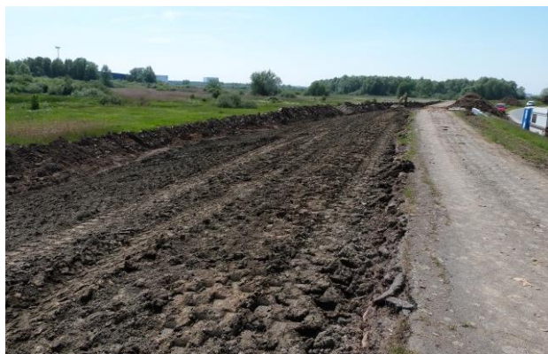
Rys. 2.17. Odbudowa wału w Bremie z lekko zanieczyszczonego urobku czerpalnego (Z2 + TBT), roboty ziemne latem 2014r.
