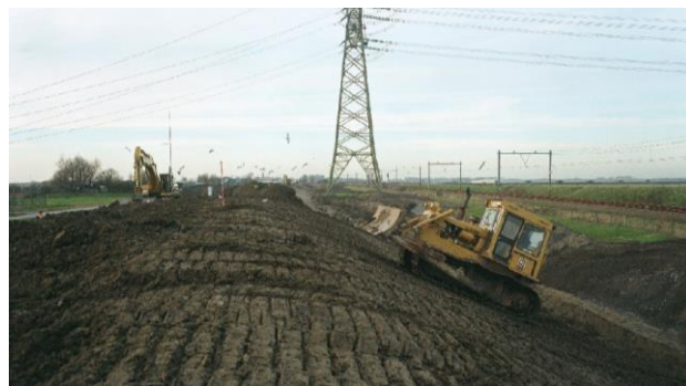
Rys. 2.20. Budowa wału w Hoek van Holland [20]
