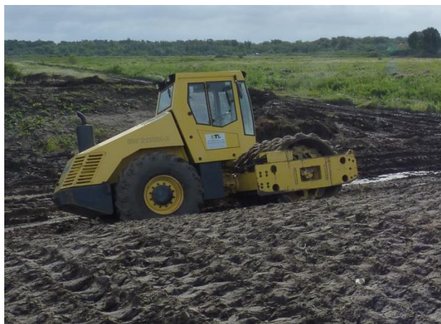
Rys. 5.5. Zagęszczanie DM walcem okołowanym
