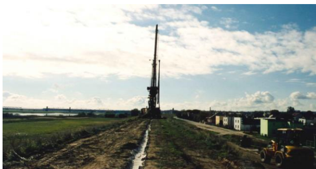
Rys. 5.9. Wykonywanie przestony (Moebius Polska)
