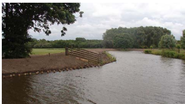
Rys. 2.19. Wał zbudowany z urobku czerpalnego, bezpośrednio przy brzegu drogi wodnej w Holandii [20]
