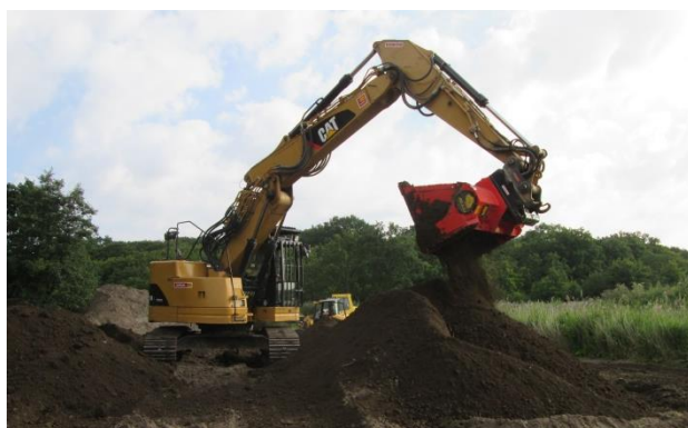
Rys. 5.3. Homogenizacja DM za pomocą sita na koparce
