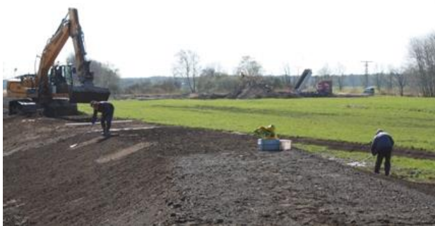
Rys. 5.13. Wysiew i ręczne grabienie na wał pilotażowy DredgDikes
