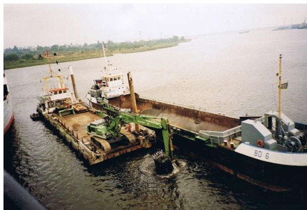
Rys. 2.1. Roboty pogłębiarskie koło tunelu Warnow w Rostocku, bagrowanie organicznego urobku pylastego
